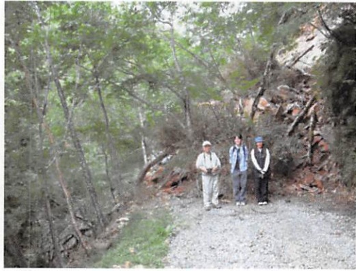
猿留川林道7・3 km地点。 現在も修復されたいない。
