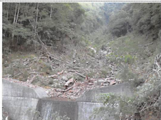
猿留川林道右岸。猿留川に流れる沢筋に見られる崩落。樹木も大量に流れたと考えられる。
