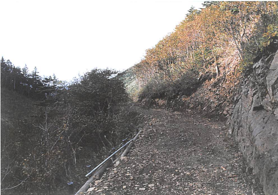
写真2. 斜面上方に法面を削り取り、斜面下方にも土砂が崩されている。
