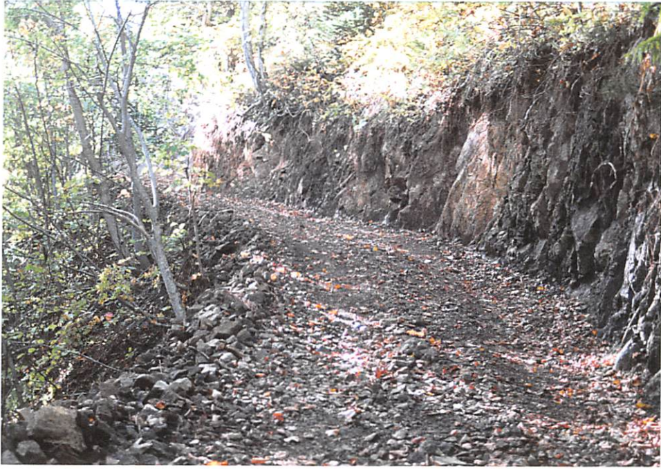
写真5. サクラソウモドキやダイモンジソウが咲く森林内の岩場を削り取り、森林生植物が咲き乱れる斜面下方には土砂が崩されている。
