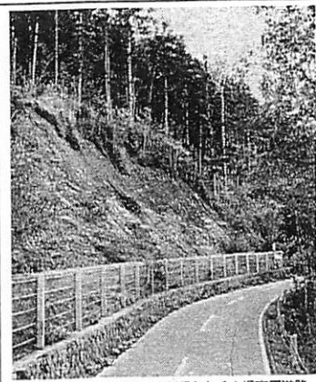
特殊工法により固化工事が行われる士幌高原道路計画線の鹿追側トンネル坑口わきの法(のり)面
