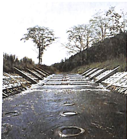
網走管内の止別川に設けられている魚道
