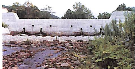
砂防ダムに魚道が設けられていないため、これより上流への魚の移動は出来ない状態にある。
