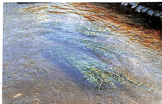
改修河川内に瀬、淵を満足させるために設けられた生息用ブロック (止別川)
