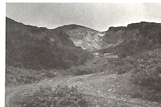
図-12 黒岩トンネル南方「くずれ」地区に見る大規模な地這り地形
