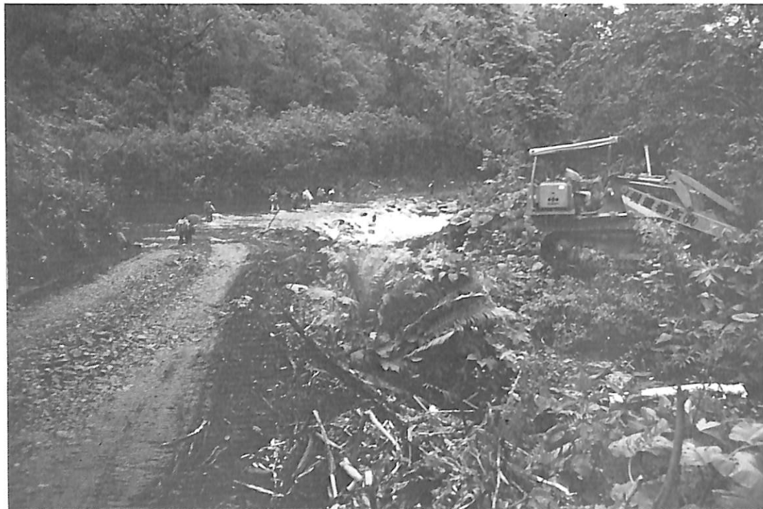
札内川、砂防ダム建設のための作業道 ブルドーザーが無惨に木々をたおしていく
