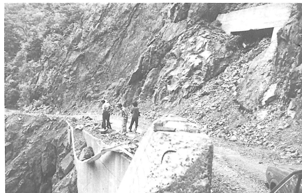
コイボクシュシベチャリ林道 地質がもろいため法面が安定せず崩落をつづけている。
