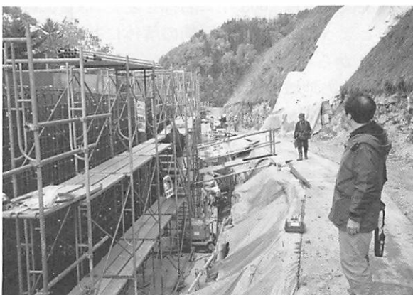
写真2 擁壁を打ち込む(茂足寄・上螺湾工区、2006年10月15日)
