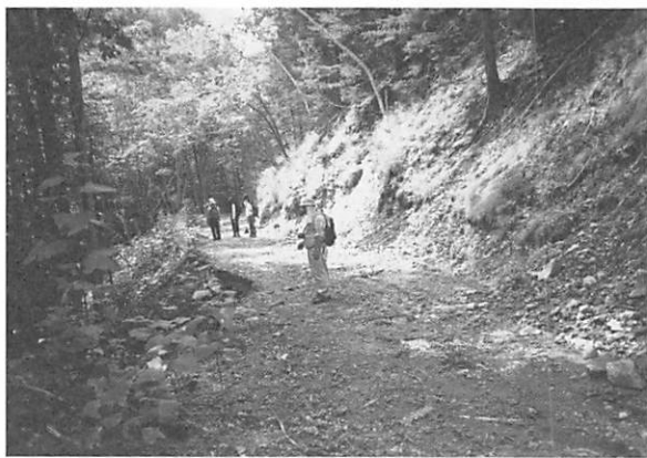
写真4 大規模林道予定ルートを歩く。地質が脆く、地すべりも見られる。(上足寄鳥取・茂足寄工区、六百三十七点沢川2ノ沢林道、2006年8月27日)
