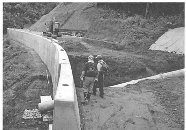
写真3 延びてきた擁壁。水源に近い(茂足寄・上螺湾工区、2006年10月15日)
