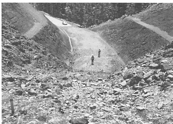
写真5 天日に晒された峰越し林道 (茂足寄・上螺湾工区、2006年6月25日)
