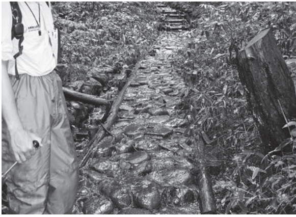
写真7 コンクリートで固めた敷石登山道（尾瀬）
