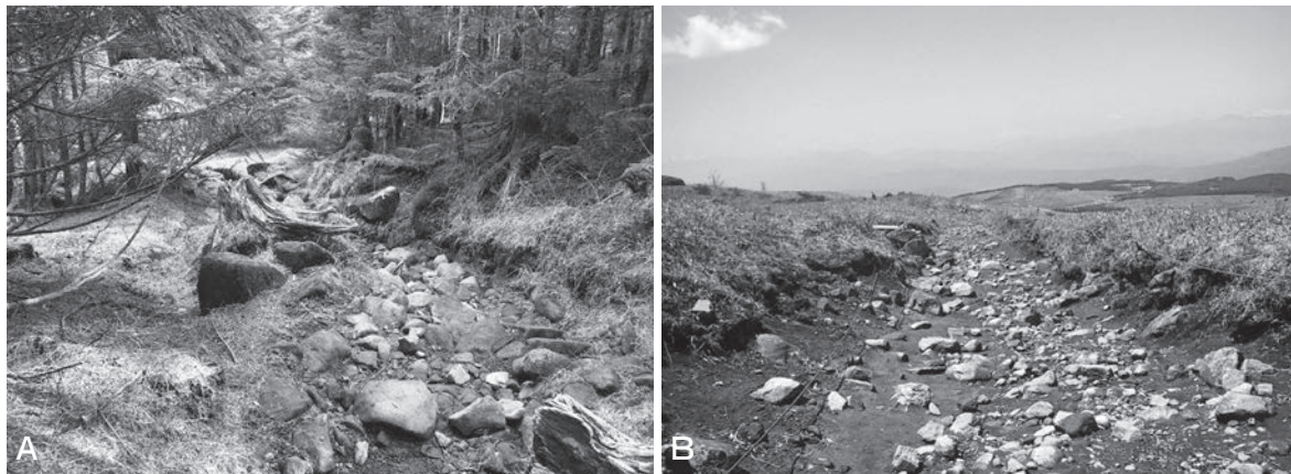
写真3 洗掘され、降雨時と融雪期のみ流水が出現する登山道 (A：長野県八ヶ岳、B：長野県霧ヶ峰)
