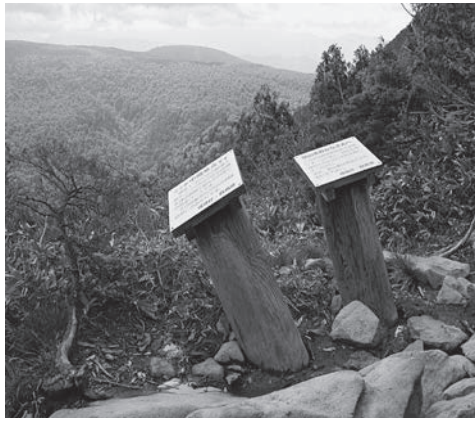
写真9 積雪グライドで斜面下方に傾斜した標識(尾瀬)
