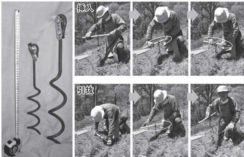
写真12 スクリュー杭とその挿入と引抜
