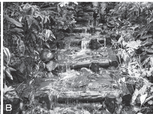
写真6 階段工と側面の蛇籠の組合せ (A)、年月が経過してなじんだ階段工と蛇籠の組合せ (B) (ともに尾瀬)
