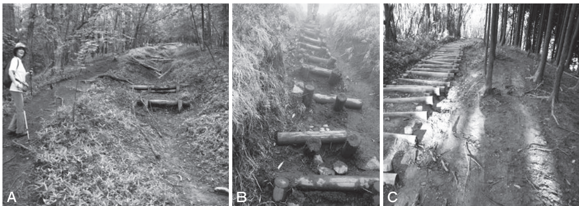
写真10 丸太階段と並行するスロープ道 (A：瑞牆山、B：丹沢、C：埼玉県秩父山塊正丸峠)
