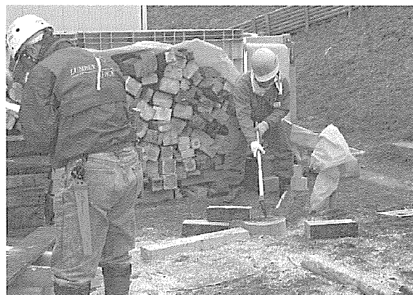
写真5 柱・梁などのきれいな木材は薪となった
