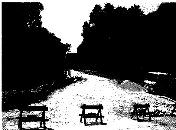
写真1 風力発電施設の建設道路（静岡県南伊豆町）
