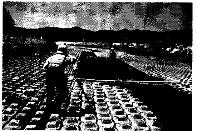
写真9 コンクリート・ブロックの一部をはずしてもらった再改修区間。
