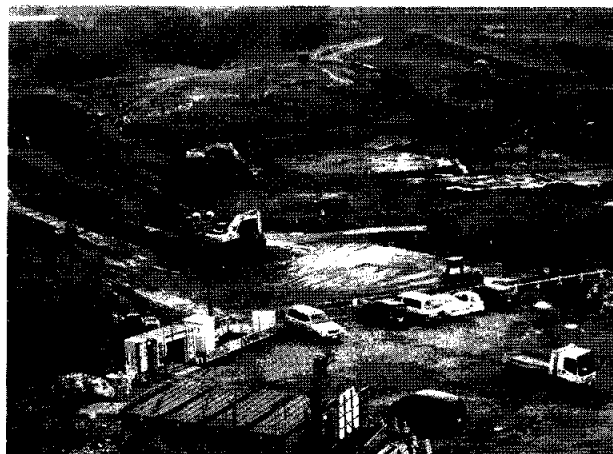
写真2 ダム建設予定地(2008年10月18日撮影)。ひっきりなしに工事のトラックや重機が行き来している。
