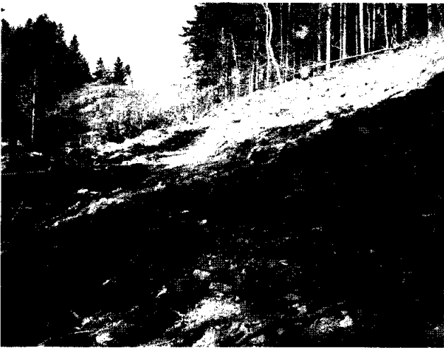
②道路幅の何倍もの広さで森林が伐採され、土砂は谷側に落とされる（滝雄・厚和線）
