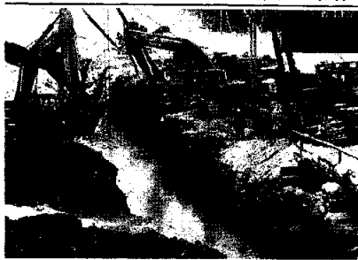
土砂流出などで河川の生態系への影響が心配される「サハリン2」のパイプライン建設工事—2005年12月、サハリン環境ウォッチ撮影、F o E ジャパン提供
