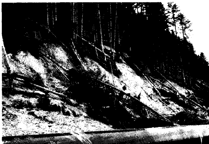
写真5 土砂くずれがパイプラインを圧迫している例
