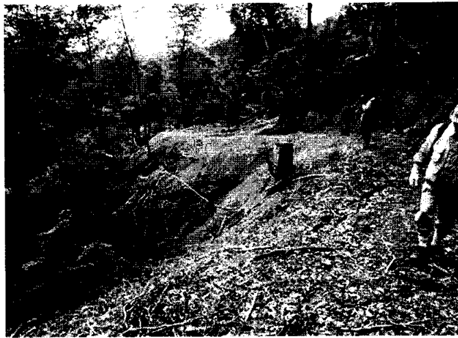
写真2 作業道による破壊 (檜山国有林)
