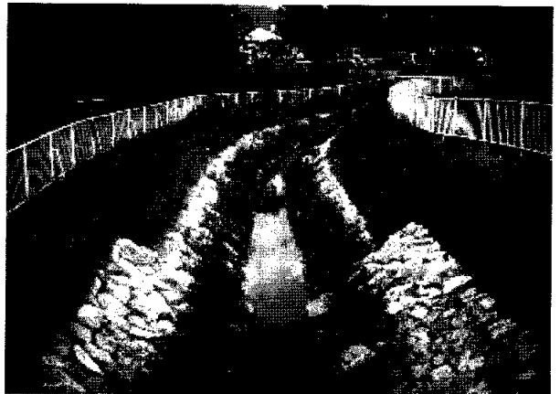
写真5 河川改修された小支流。自然に配慮した工法をとっているが、改修後イトウの稚魚は見られなくなった（筆者撮影）
