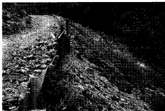
写真 3. 七曲がり最上部（地点④）における杜撰な路肩工事
