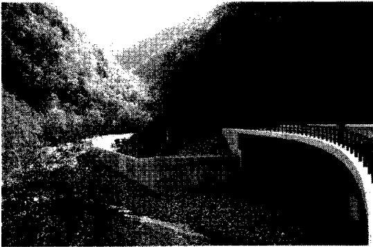
図5 十勝側、工事先端の七ノ沢橋、左手の七ノ沢に沿って道路が延びる予定
