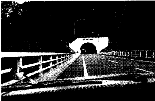
図7 札内ダム沿線の道路、橋梁とトンネルばかりの「金喰い虫」
