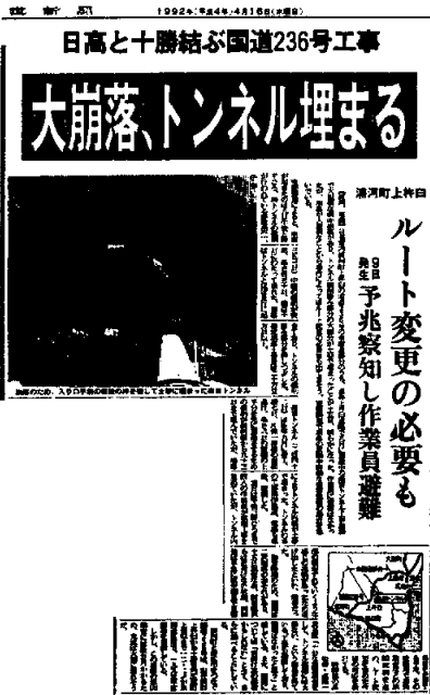
図3 楽古トンネル（天馬街道）が大崩落（北海道新聞1992年4月16日）
