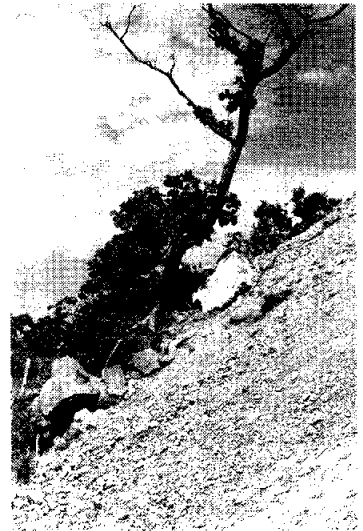
4 法面崩壊により樹木のざり落ちが多かった。1972年7月
