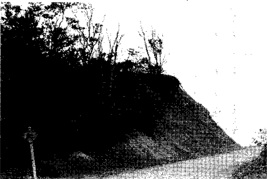
3 尾根筋路、崩壊した上の木は枯れていく。各所でみられた。1972年7月
