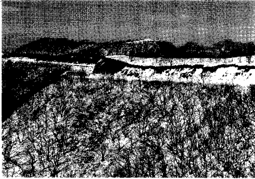
1 開削された尾根筋、市街地から見えないため、多くの市民は工事に気づかなかった。1972年1月 この尾根筋はこのまま20年間放置状態にされた。
