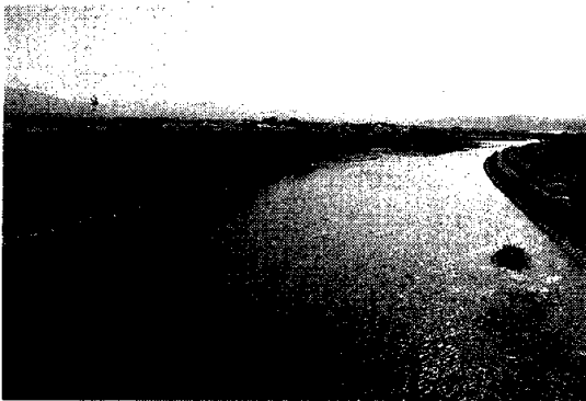
⑩八雲町の市街地を流れるユーラップ川。川岸まで柳の木がうっそうと繁っていたのだが、サケの密漁対策として伐採されて以降、コンクリート護岸へと変えられた。流れが護岸に引き寄せられ、水際の大切な空間を失った。子どもたちの川遊びは禁止されることになった。
