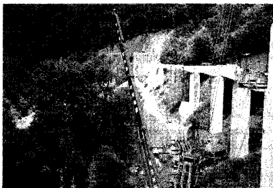
写真1 日高横断道建設現場で
