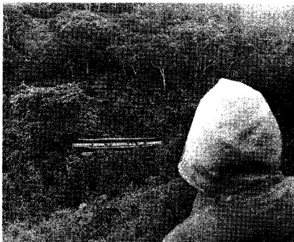
写5 狩場山 なだれで飛ばされた橋
