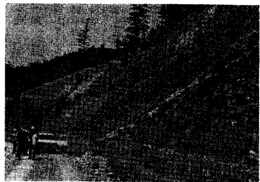
礫層を切ったため崩落が進行 (ポンケチャロマップ林道)
