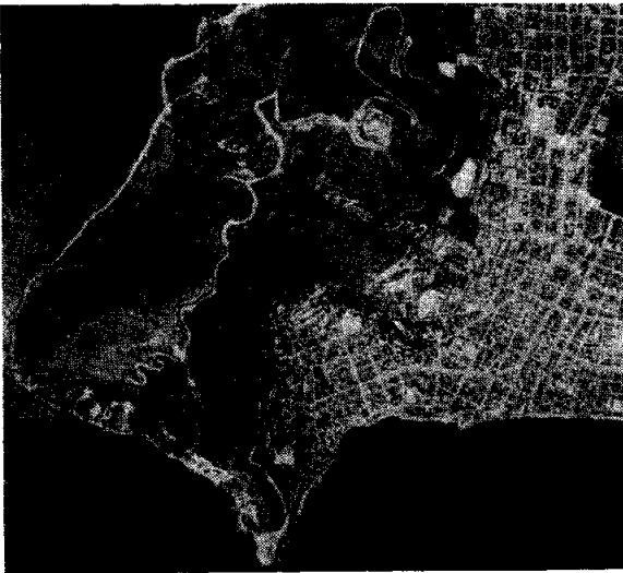
上空から見た函館山、尾根の 白線は未完成車道 (S 43. 8)
