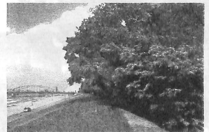
河川空間の樹木群と旭橋
