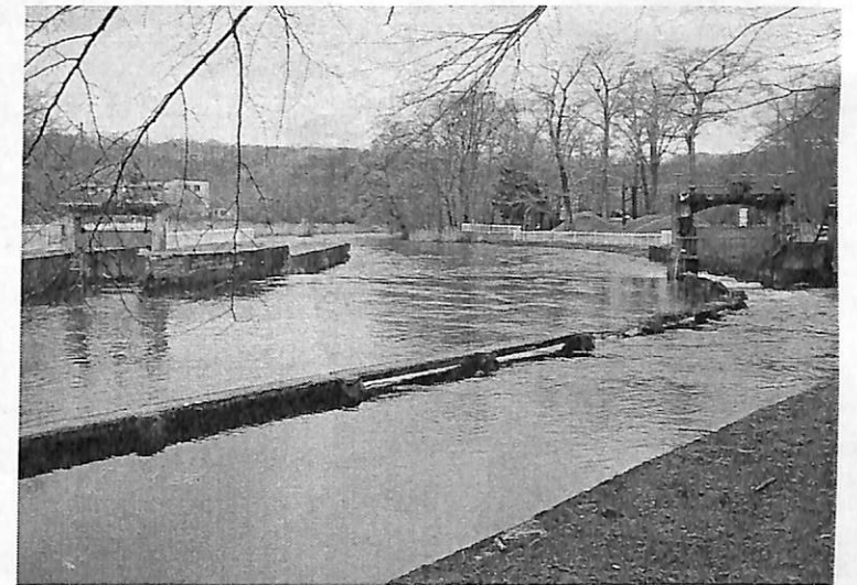
現在の頭首工全体を千歳川上流からみたところ、堰は水面下にあり目立たない
