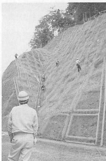
滝上・白滝区間(白滝側フリーフレーム工法)
