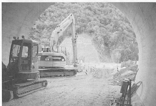
滝上・白滝区間(滝上側トンネル工事)
