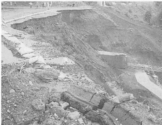
平取・新冠区間（災害復旧現場）
