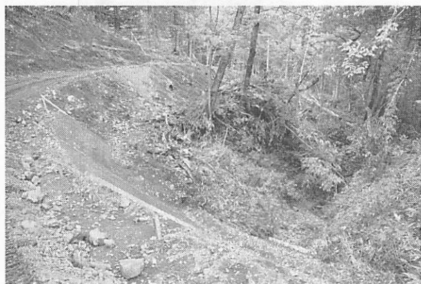
滝上・白滝区間(滝上側トンネル工事用道路)
