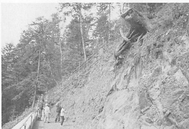
滝上・白滝区間(滝上側工事現場)
