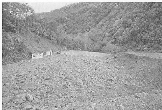
滝上・白滝区間(白滝側残土処理場)
