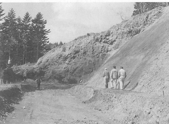
大規模林道阿寒側工事現場（最終地点）
