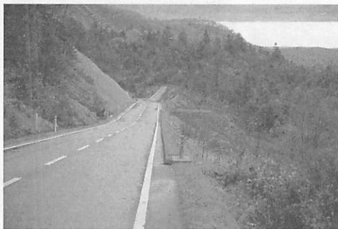
完成間もない大規模林道。人家に最も近いが通る車はほとんどない。
