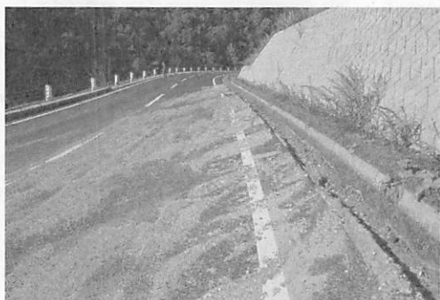
真新しい舗装の上を、雨が削り取った土砂が走る。側溝は形ばかり役に立っていない。
