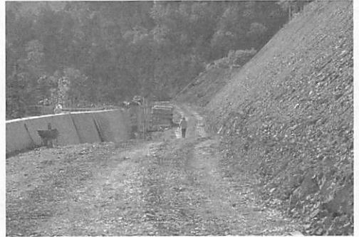
稜線に向かってまっしぐらに突き進む工事道路。尾根を越えると白滝側になる。
