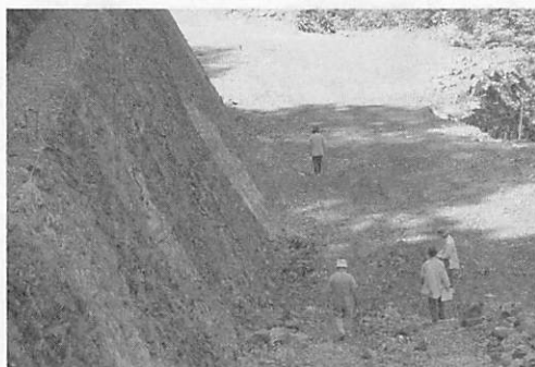
白滝側工事の先端部分。雄柏山を挟む両側の渓谷は、このような急斜面の連続である。
