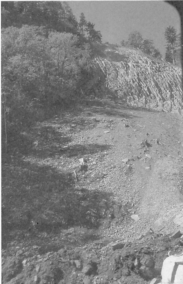
自然破壊は、切土・盛土などの工事を通して、様々な形で広がる。壊すのは一瞬、復元は容易でない。
