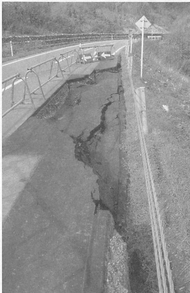
凍上・路盤の沈下で崩れた路面。2箇所数メートルにわたって続いていた。
