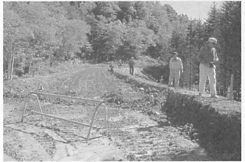
河川横の湿地を大規模に埋め立て工事が進む。洪水を調整する機能が次第に消える。
