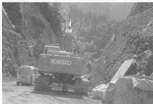
岩盤をコの字にくり貫いていくような工事現場。膨大なエネルギーと金が消える。
