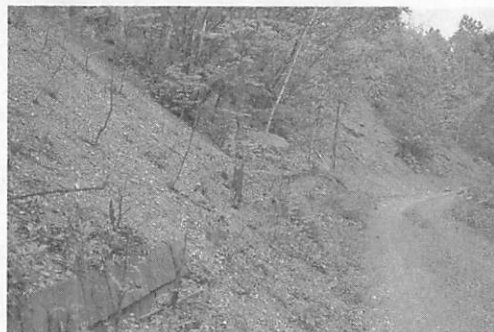
足寄の道路予定地。地すべり地形が集中する。既存の林道でも崩壊が発生している。
