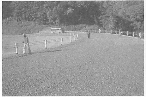
溪流の源頭を悠々と跨いでカーブする工事道路。
