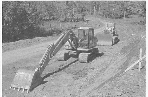
工事道路の先端は、まさしく森くい虫のアゴ先である。
