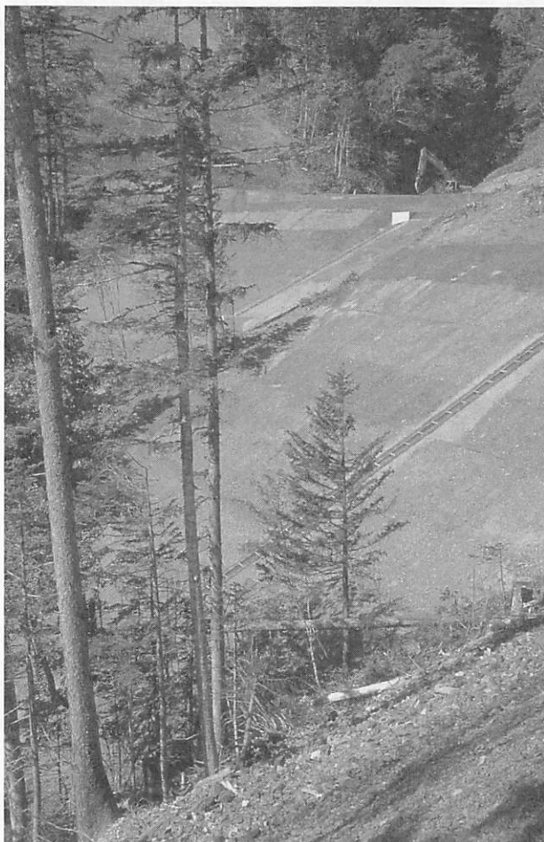
機械力にものを言わせて、山腹を削りに削る。急峻な地形の道路開発は線ではなく面の自然破壊が進む。
