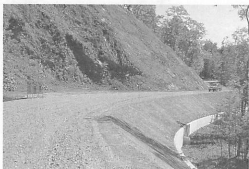
川沿いに山すそを削りながら工事道路は延びる。
