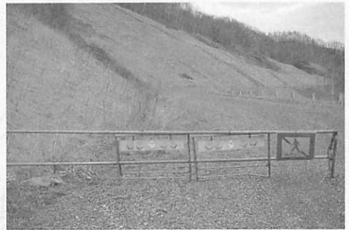
海岸線からはるか離れて縦走する道路。完成しても有効に使われる可能性はない。
