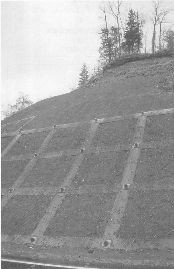
樹林が切り払われ、コンクリートを打ち込まれた法面が、沿線随所に登場する。
