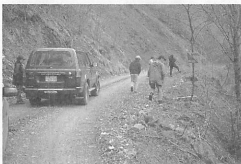
拡幅が予定されている既存林道。風化の著しい地層と急峻な地形が立ちはだかる。
