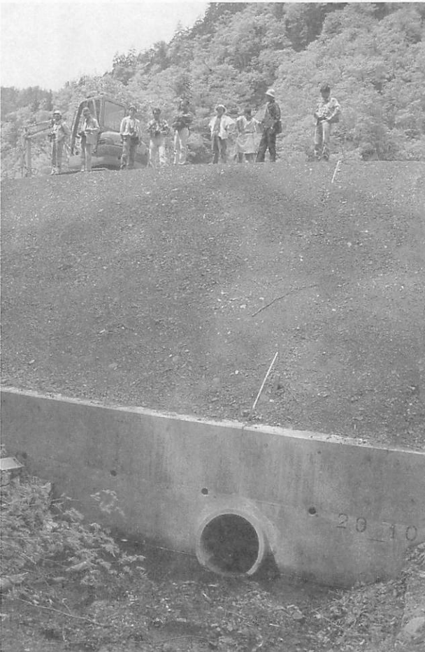
林道と直交する支流。この小さな径の管が目詰まりすれば、道路は一挙に断ち切られる。
