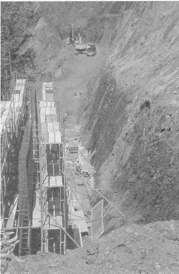
道幅さえ確保できない急斜面。コンクリートの擁壁でようやく路盤ができる。
