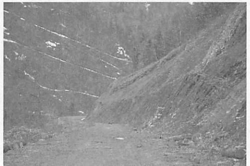
周辺の山に切る木はすでにない。工事が新たな裸地を付け加えるだけ。
