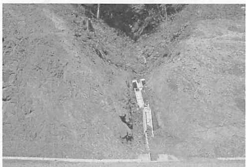
断ち切られた支流。申し訳程度の排水溝は少しの雨で簡単に崩れている。
