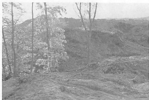
国道274号線側から始まったばかりの工事現場。小高い丘は頭頂から削られる。
