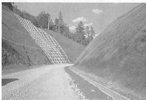
道路の両面に森林を剥ぎ取られた巨大な法面が続く。
