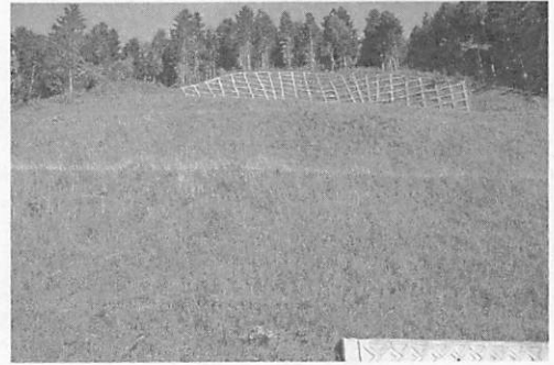
一見安定しているかのような法面も、崩壊・修復が繰り返されている。
