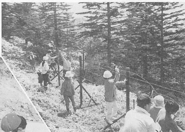
シカの食害を防ぐための柵づくり 資材建てと有刺鉄線張り
