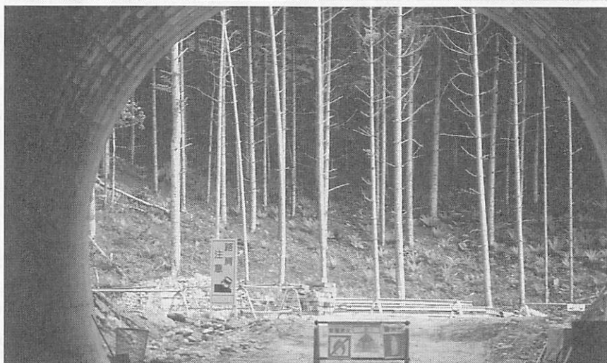
足寄側トンネル工事
