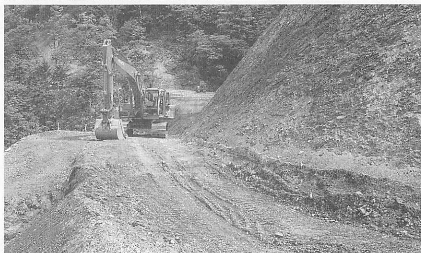
白滝側工事現場
