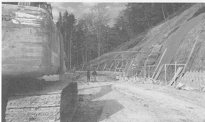
足寄側工事現場
