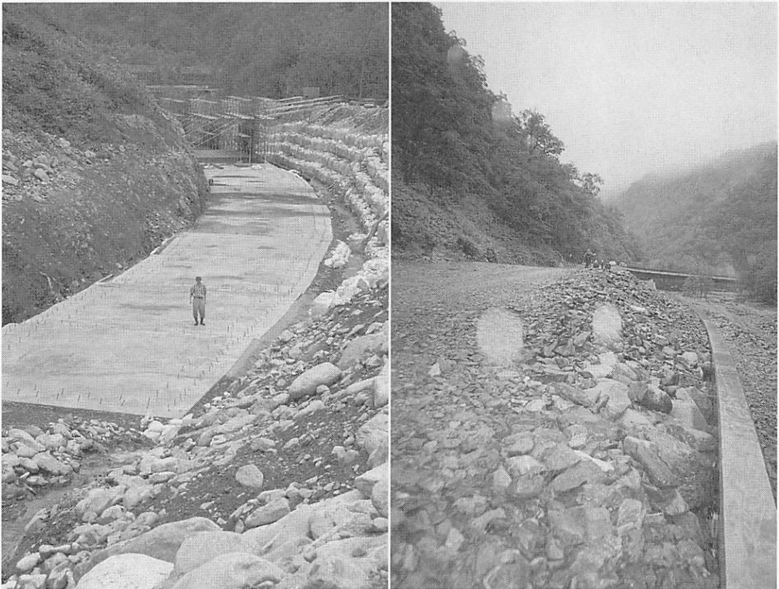
7の沢工事の進捗（同じ場所。左が1998年、右が2000年）
