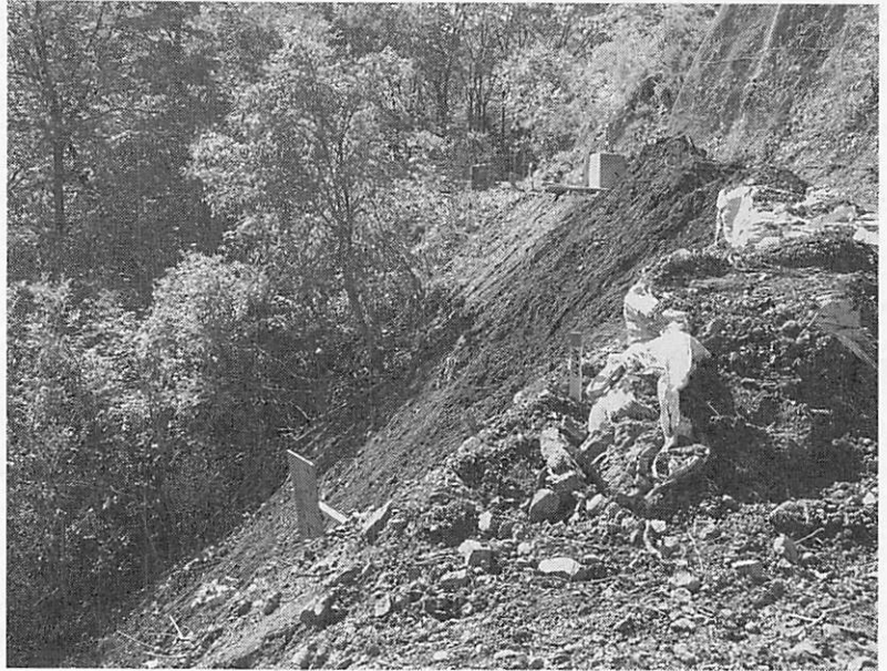
高見ダム上部林道の崩壊所
