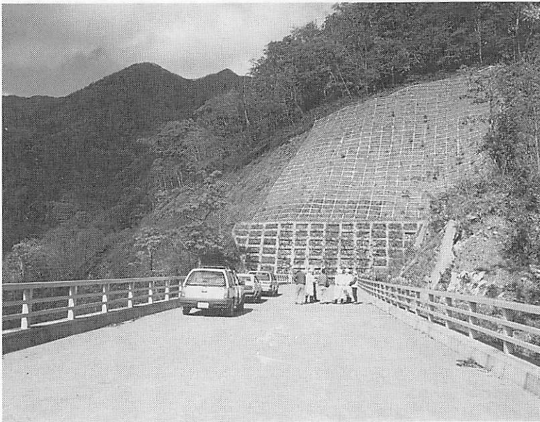
静内側・工事最奥現場、暎光橋（289m）、千石トンネル手前
