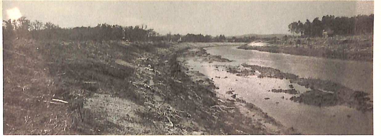
河川改修の始まった猿払川本流水面を覆うようにはえていた 樹木はことごとく伐採され、重機で法面の工事をしている
