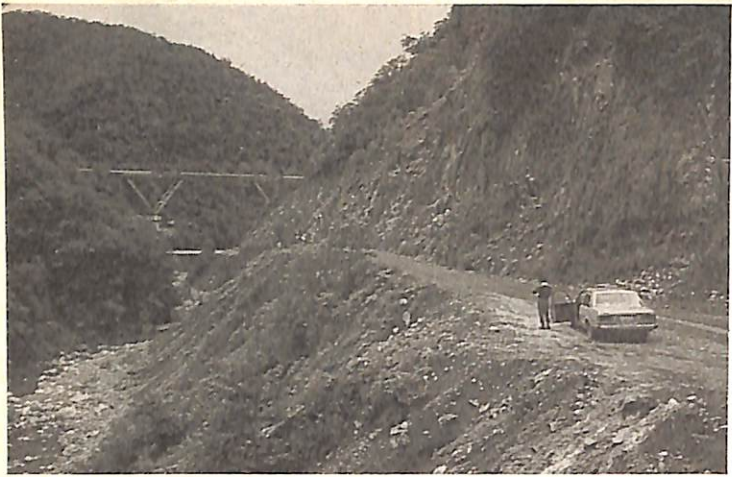
完成しつつある巨大な橋梁 (7月11日)
