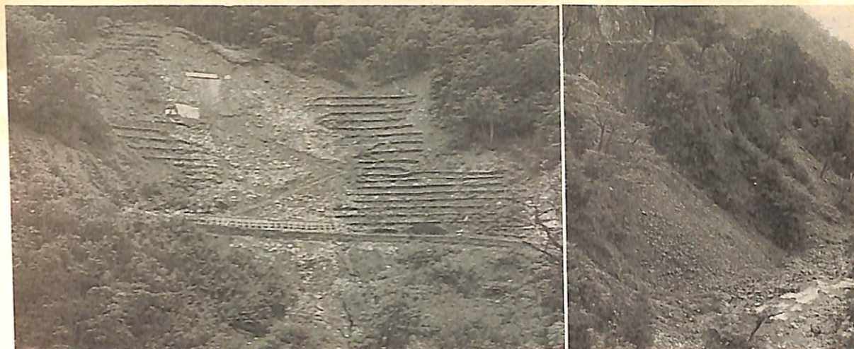
繰り返しの法面補修にもかかわらず、再び崩れ ていた。(7月11日)
