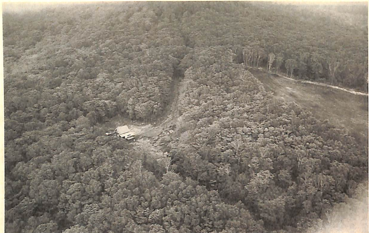
写真右手が第1期着工部分(民有地)。昨年12月オープン。中央、白鳥ヒュッ テより上部の国有林(水源かん養保安林)が第2期工事予定地。
