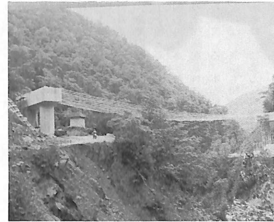
ナナシノ沢出合、工事現場
