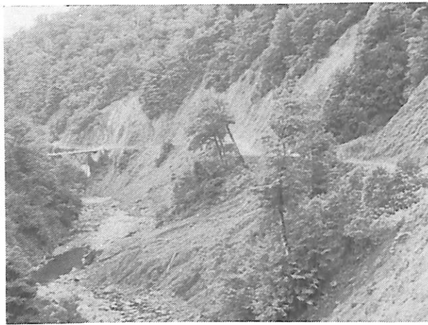
林道の崩落による土砂を沢に投棄
