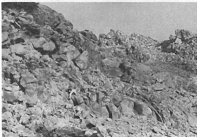
(P6) 硫黄山西南側斜面 (安全なルートがない)
