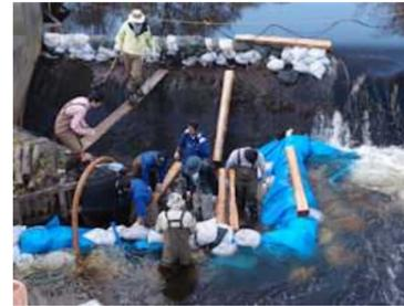
今回の魚道は、残った三角水制の一つを使い、直方体の導流堤を設置し小さなプールをつくって魚の遡上を助けるものです。浄水場の堰堤には直接固定することが出来ないため、自重と強度を上げるため、60cm幅のコンクリート製U字溝を2基並べてアンカーで河床の水叩きコンクリートに固定しました。内部に角材を組み上げ、土嚢を詰めています。
