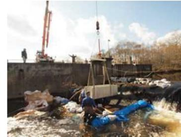
U字溝が1トンあるためクレーンを使用しました。魚道付近の川底の砂も流されてしまっていたので、下流で作った土嚢の移動にもクレーンが活躍しました。
