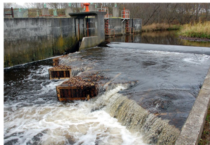
三郎川では簡易魚道設置後、上流部でそれまで見られなかった大型淡水魚の遡上が確認され、魚道の設置効果が裏付けられました
