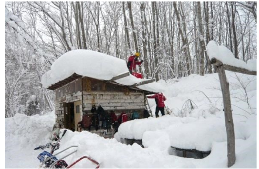
1mは積もった第二小屋屋根の雪下ろし
