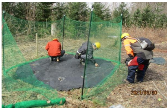
54 小班 3m 角食害防止網内の植栽木確認
