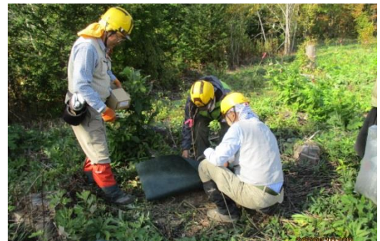
防草シートの敷設
